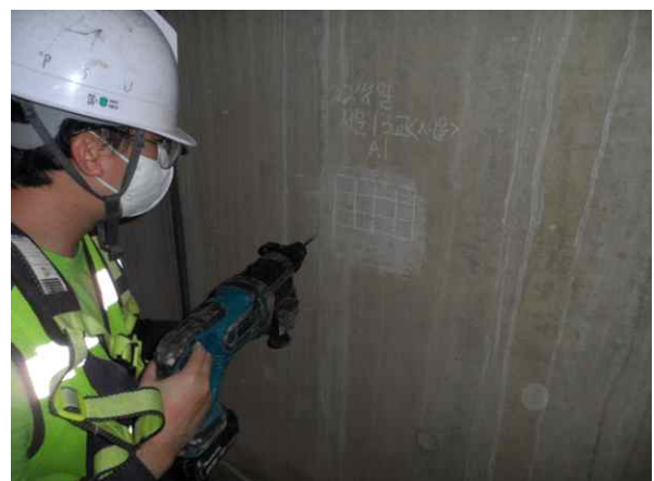
탄산화깊이 측정 현황
